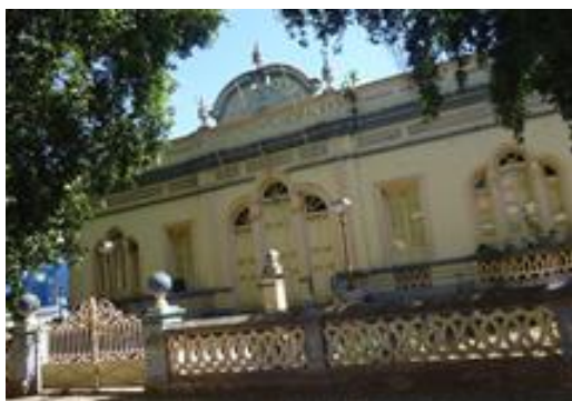
Biblioteca Municipal de Cáceres/MT Fechado a aproximadamente 02 anos para reforma
