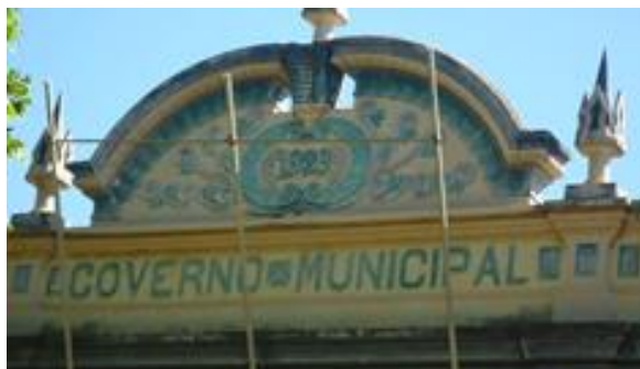
Detalhe da fachada da Biblioteca Municipal de Cáceres/MT (1929)
