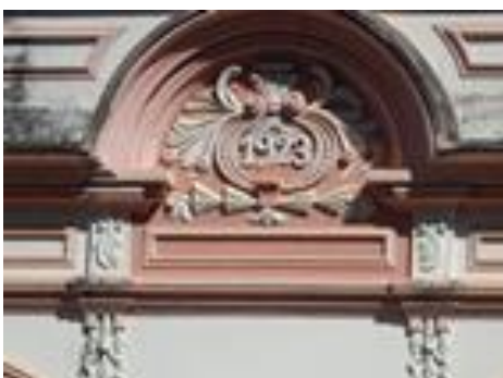
Data de fachada de casarão no centro histórico de Cáceres/MT
